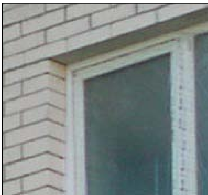
Рис. 2 Фотография оконных проемов перекрытых декоративными перемычками.
